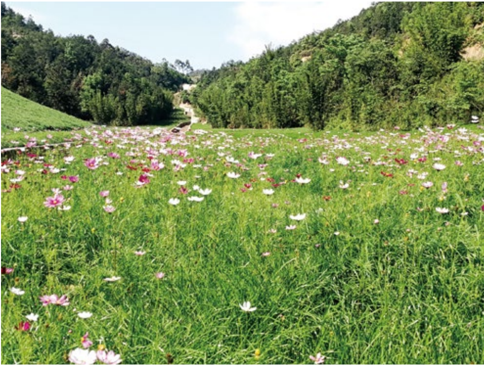
赣县区大田乡废弃稀土矿区重金属综合治理工程（一期）矿区现场
