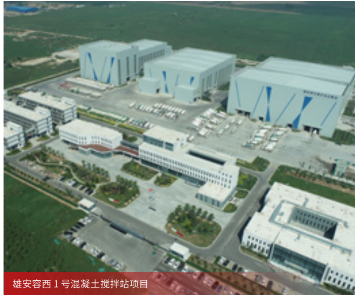
雄安容西1号混凝土搅拌站项目
